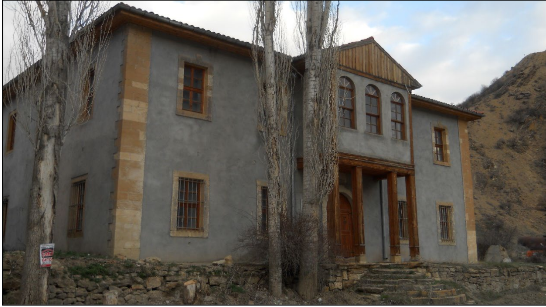
Resim 30: Kuruçay Hükümet Binası.
