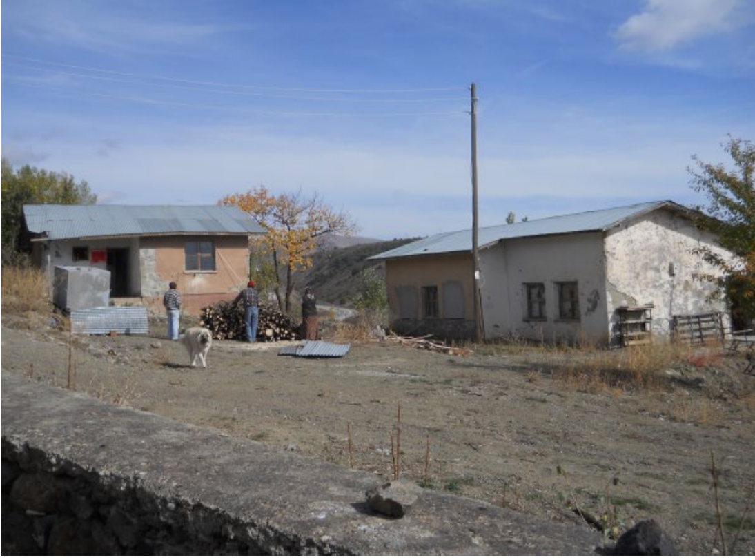
Resim 19: Köylerde bulunan eski ilkokul binaları. Bakım ve onarımı yapılması halinde “Eski Eserleri Ve Folklorik Malzemeleri Araştırma - Toplama Merkezi” olması yanı sıra “Çok Amaçlı Hizmet Binası” olarak değerlendirilecektir .
