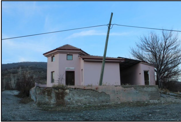
Çatalarmut/Esesi köyü- Ali-cerrah Türbesi'nin bugünkü durumu.
