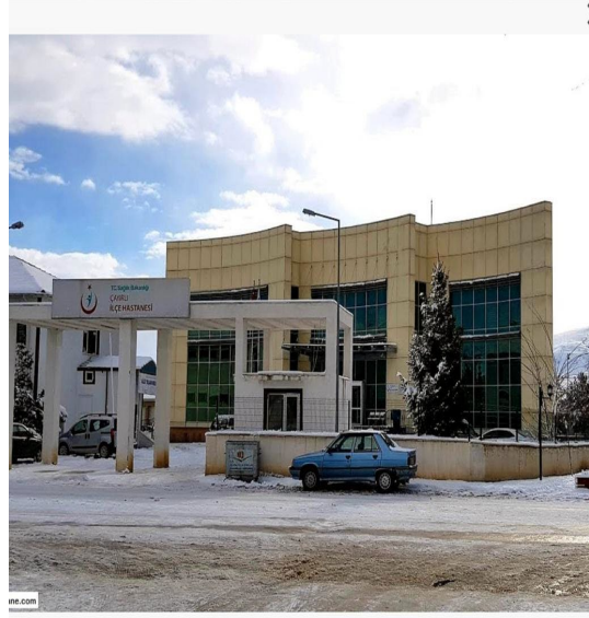
Yeni Hastane Hizmet Binasından Bir Görünüm
