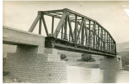
Demir köprü. Kemah- Erzincan arası
