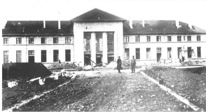
Erzincan Tren İstasyonu inşa sırasında, 1938
