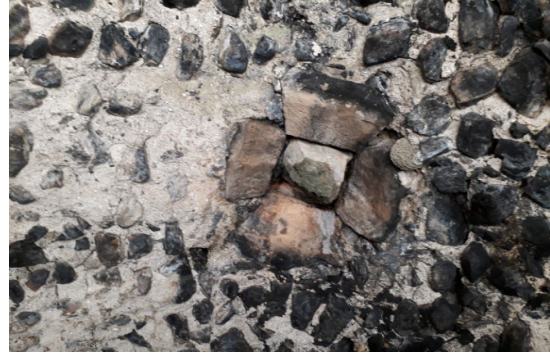
Resim: Yer Han. Kuzeydeki galerinin üst örtü sisteminde bulunan baca.
