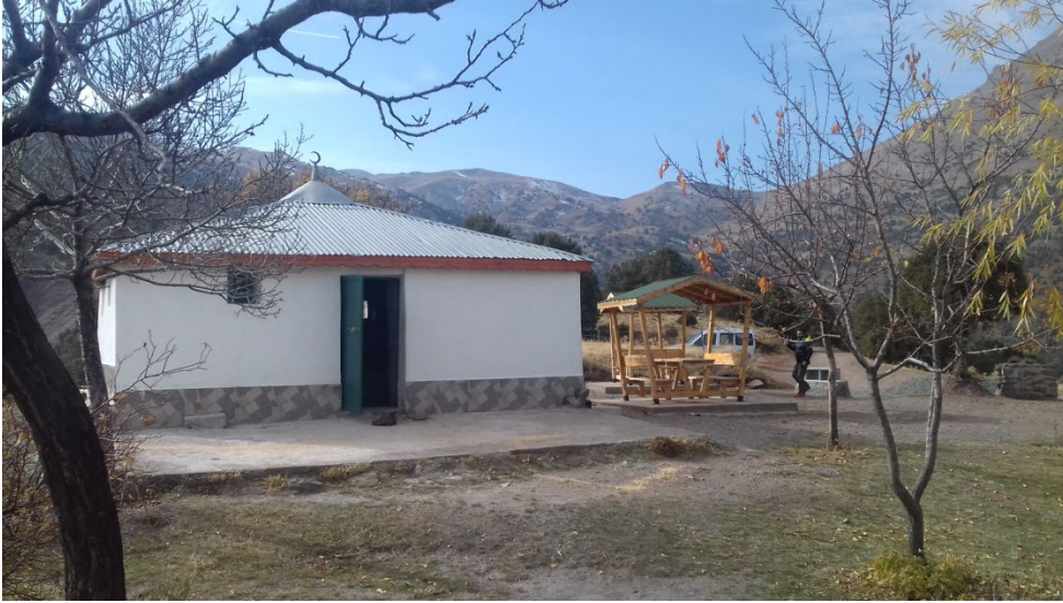
Resim 3. Acepşir Gazi Türbesinin dıştan görünümü. (foto. Tuğrul KARANLIK)
