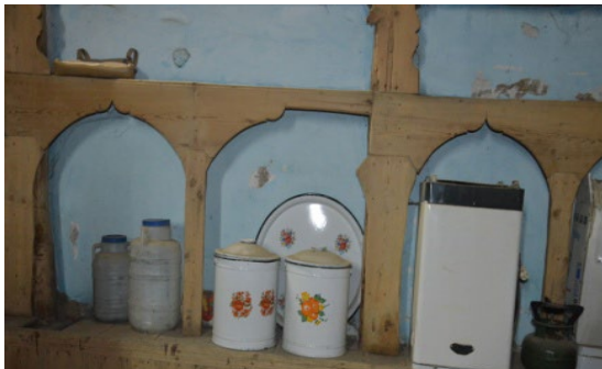
Resim 27 -Bir konak aşhanası duvar dolabı
