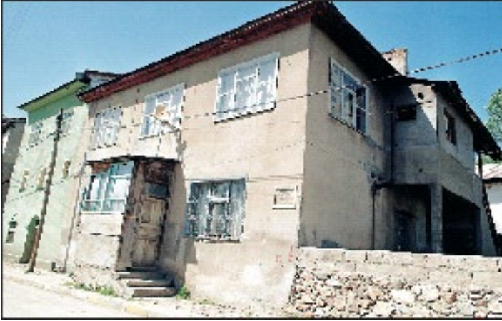
Resim 2: Atatürk'ün, Refahiye'de misafir kaldığı ev. (Onarım yapılmıştır- Fot. M. Özdemir)
